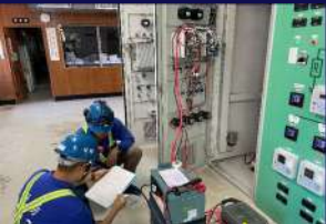
發電廠發電機保護電驛測試
