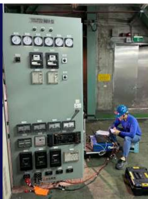
○ 盤保護電驛測試
