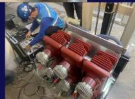
斷路器三相同步試驗
