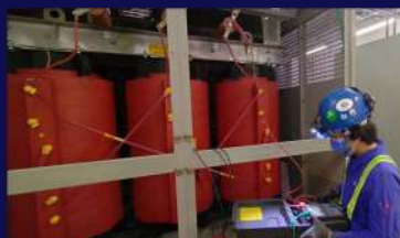
變壓器絕緣電阻量測
