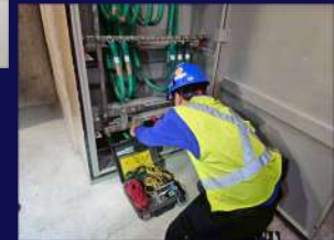
接地系統接地電阻量測
