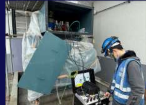
變壓器退磁量測
