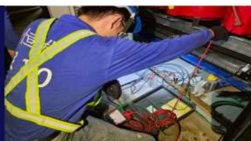
變壓器絕緣電阻量測
