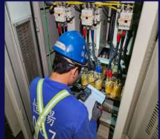
低壓盤電容器電容值量測
